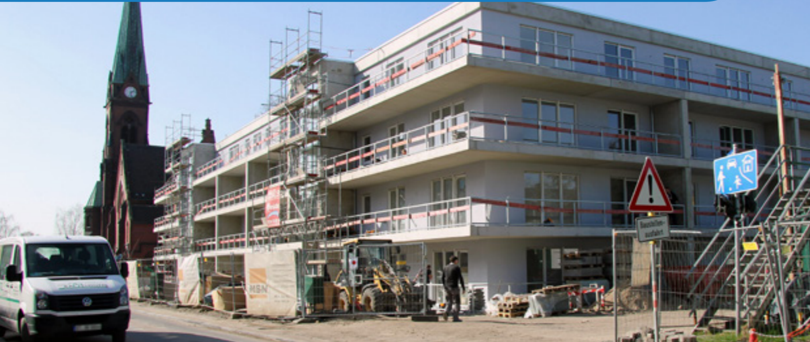
Bereits weit vorangeschritten: der Neubau des Gemeinnützigen Wohnungsvereins an der Friedrich-Harkort-Straße.
