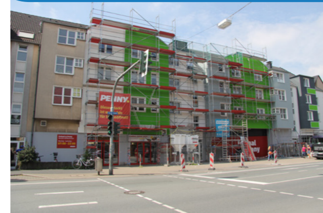
Inzwischen abgeschlossen: Die Modernisierungen an der Herner Straße.
