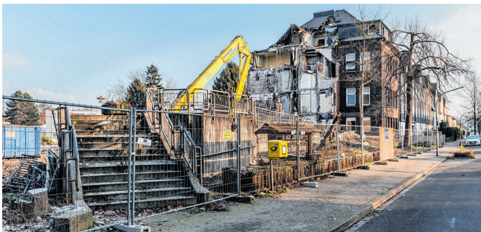
Die Abrissarbeiten am ehemaligen Haus Am Beisenkamp laufen auf Hochtouren.
