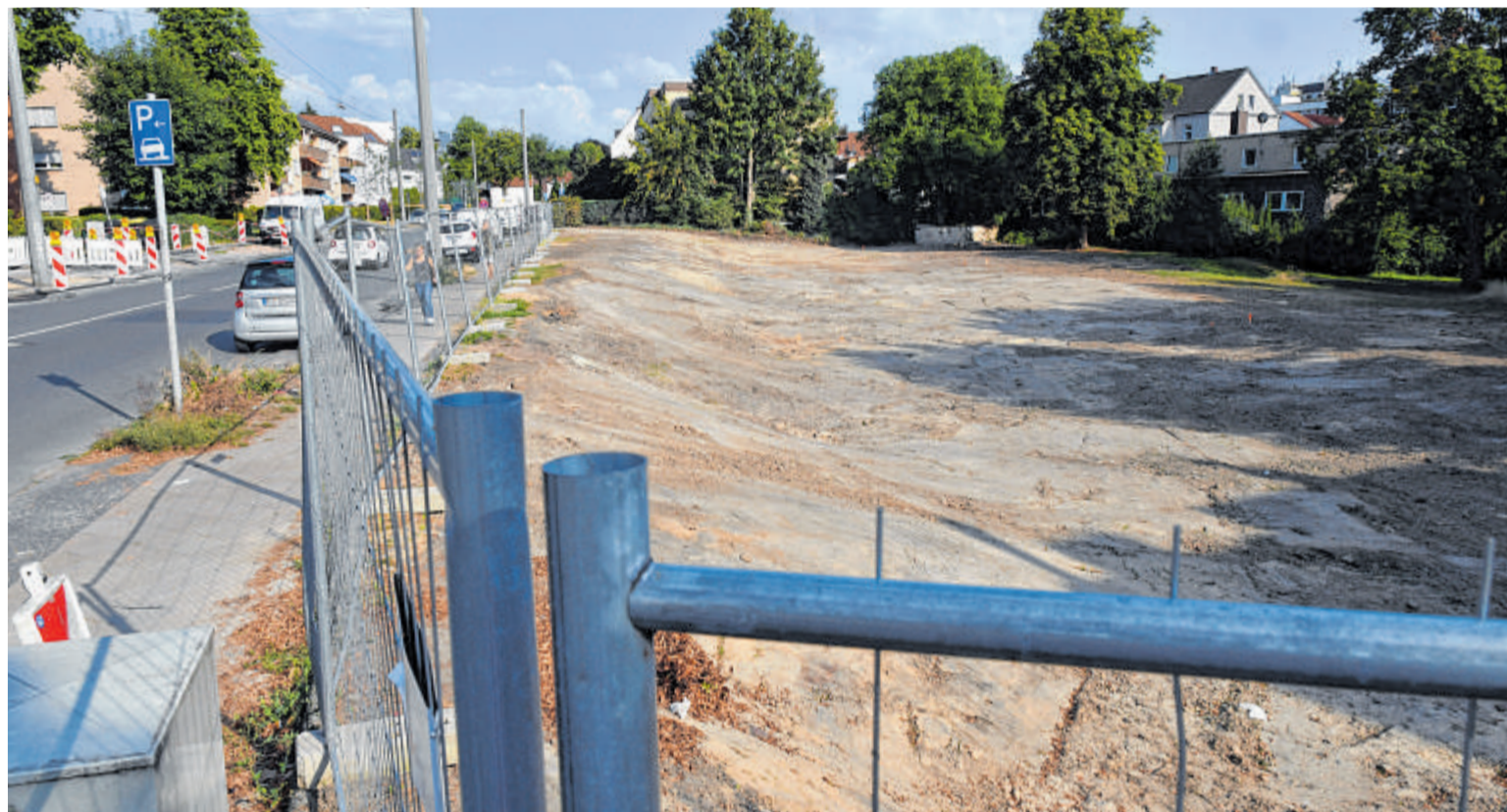
Die Baugenossenschaft Bochum hat die fünf alten Wohnhäuser Marienstraße 43 bis 53 abreißen lassen, um neues Baugelände zu schaffen..
