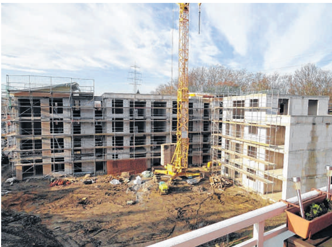
Ein Blick vom Balkon der Wohnanlage an der Parkstraße auf den Neubau an der Hüller Straße 110-114. Wenn das Wetter stabil mild bleibt, können schon bald die Fenster eingesetzt werden.
