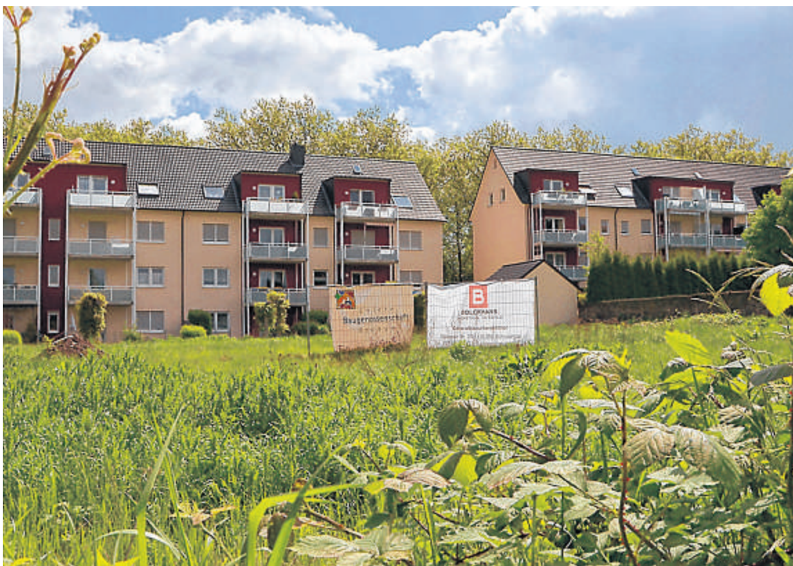
An der Hüller Straße 110 bis 114 errichtet die Baugenossenschaft Bochum die Seniorenwohnanlage. FOTO: KLAUS POLLKLÄSENER
